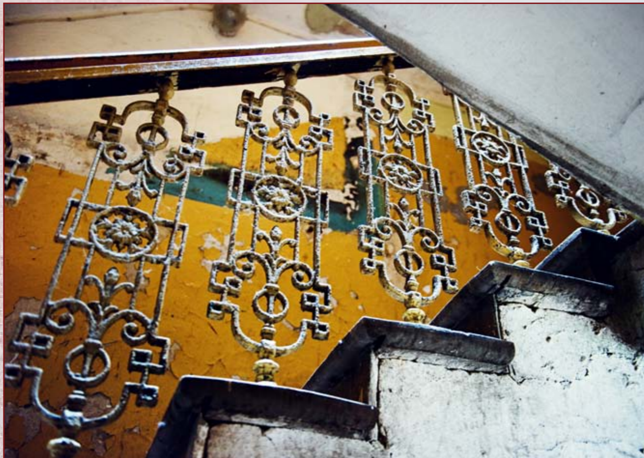
▲ Balustrada schodów w kamienicy na Ostrowieckiej. Jeden ze śladów po wielusetletniej obecności Żydów w Radzynie
